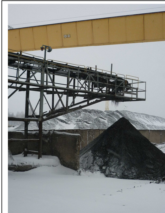
Na pierwszym planie przenośnik taśmowy układu odżużlania, w głębi składowisko węgla.
