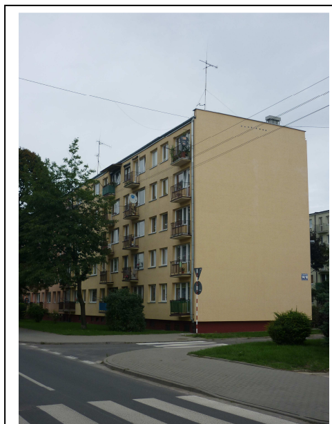
Na zdjęciu budynek z zasobów Spółdzielni Mieszkaniowej „Lokator” poddany gruntownej termomodernizacji.
